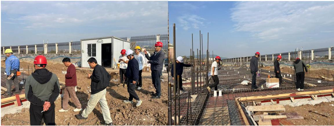
检查结果：基础工程无问题，结构工程 2 号楼 1 层构造柱钢筋绑扎偏位，
