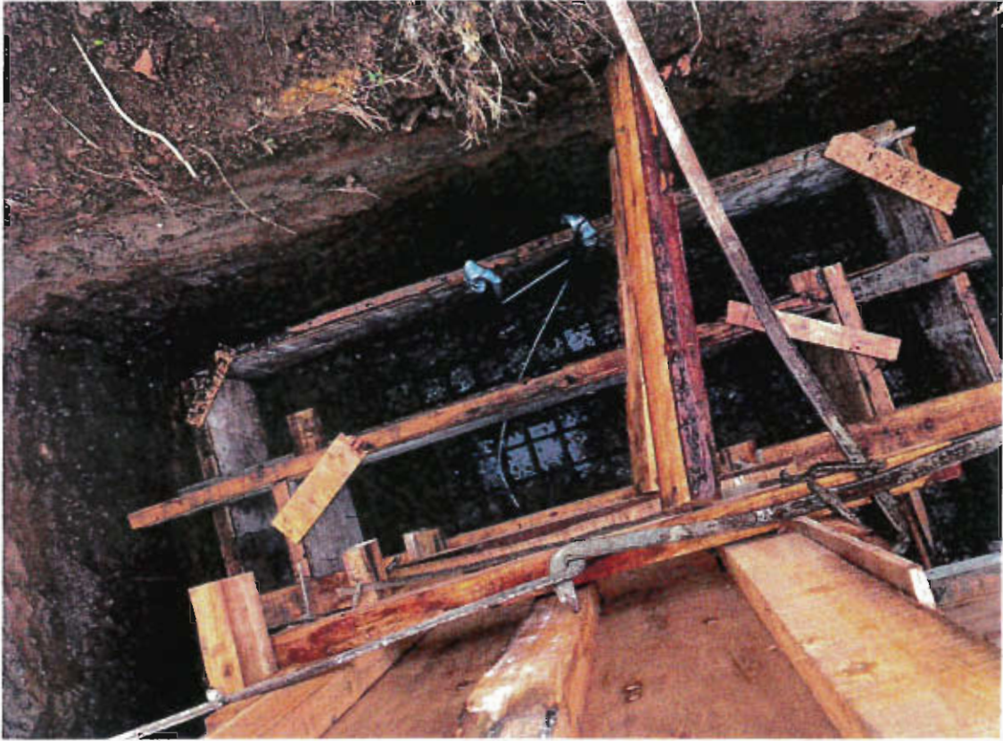
基础接地焊接
